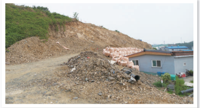
▲ 장생포 마을 재해예방사업 공사 현장
